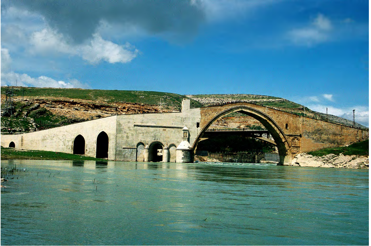
Resim 6 Batman (Malabadi) Köprüsü
